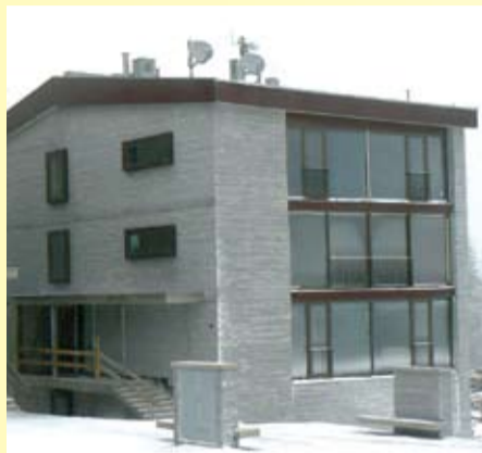
Dostavba liečebného komplexu Hviezdoslav - apartmánové byty, Štrbské Pleso
